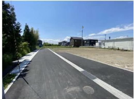
南側前面道路
