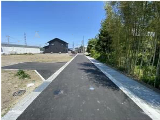
南側前面道路
