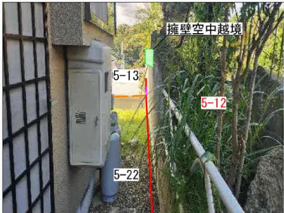
① 土留空中越境 越境幅最大47mm
