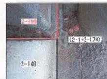
A4418(既読)コンクリート杭
