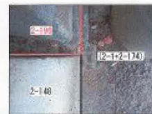
A44B(問題)コンクリート杭
