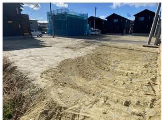
現地敷地内から撮影
