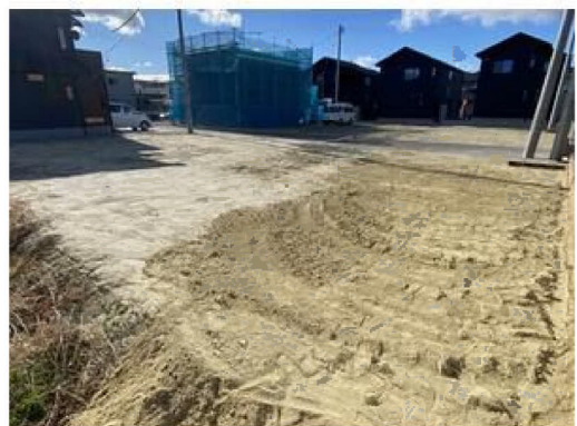
現地敷地内から撮影
