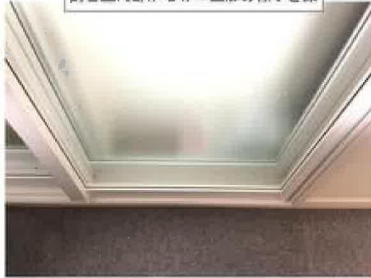
防音室内部からの二重扉の様子と床
